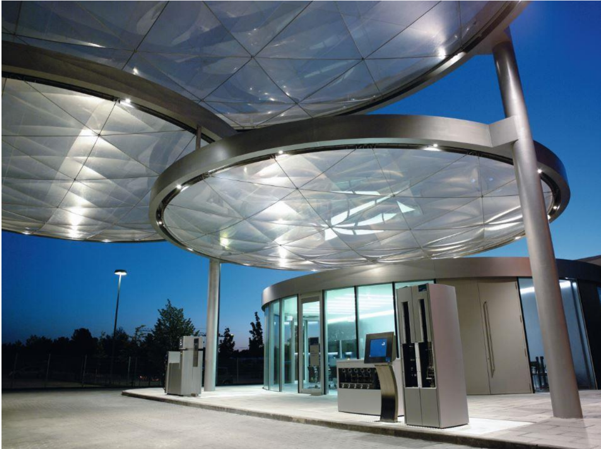
H2-Tankstelle der Linde AG im oberbayerischen Unterschleißheim: Der Industriegase-Spezialist ist Teil des Wasserstofftankstellen-Betreiberkonsortiums H2 Mobility, das unterstützt vom Bund für eine flächendeckende Wasserstoff-Infrastruktur zur Versorgung von Brennstoffzellenautos in Deutschland sorgen will. Bild: Linde AG
